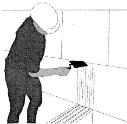
Рисунок 40 – Нанесение раствора для тонкошовной кладки на возведенную стену - нанести раствор для тонкошовной кладки на примыкающий к возведенной стене элемент кладки (рисунок 41);
